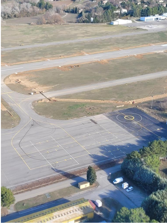
Figure 1 : Vue du parking Novembre Ouest
